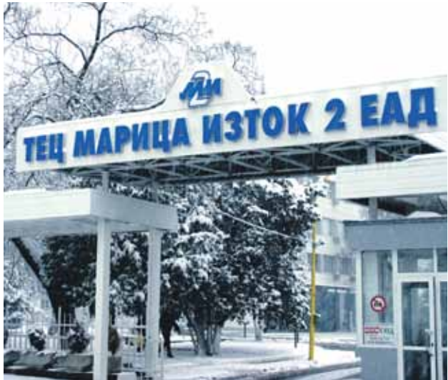
▶ На 25 февруари 2010 г. в държавната топлоцентрала влезе проверка на ОЛАФ
